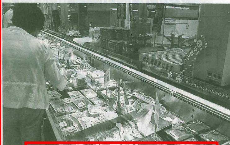
鮮魚ケースのシート下に断熱・蓄冷材を敷き冷蔵効率を高めている
